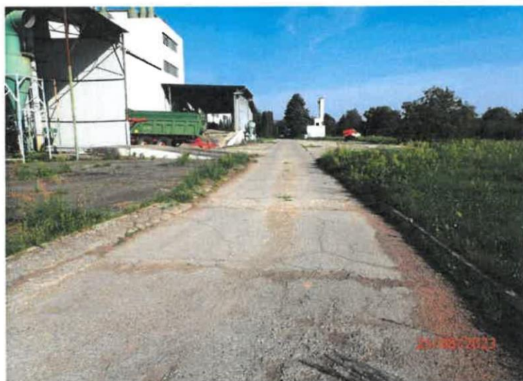
Prístupová vnútroareálová komunikácia k objektom v smere na sever
