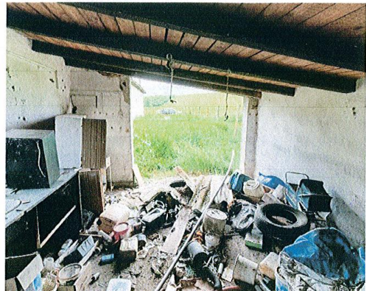
Garáž na parc. č.60 - interiér - obr.1
