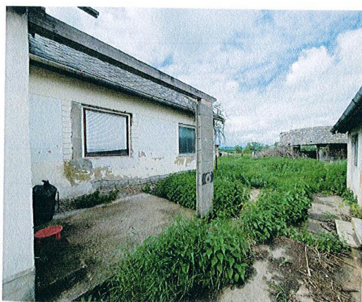
Rodinný dom súp. č.29 - pohľad do nádvorja
