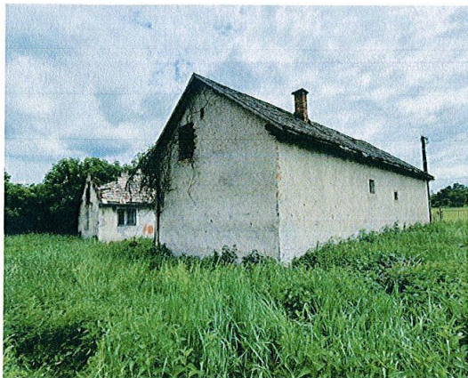
Rodinný dom súp. č.29 - severný pohľad
