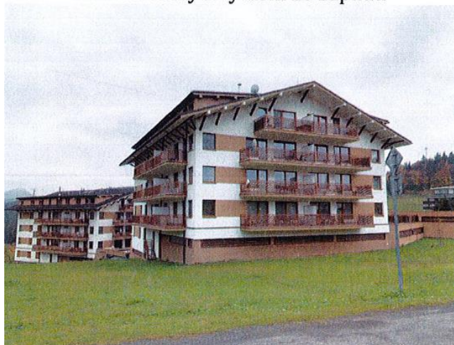
Pohľad na bytový dom zo západu
