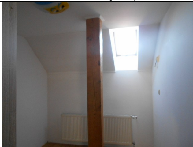
Pohľad na radiátor + okno v podkroví
