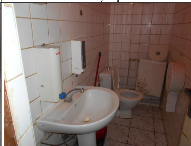
Pohľad na WC + umývadlo
