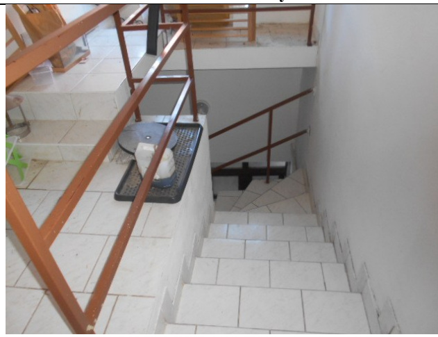
Schody na podkrovie
