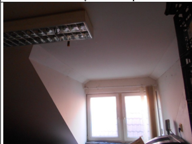
Pohľad na okno v podkroví
