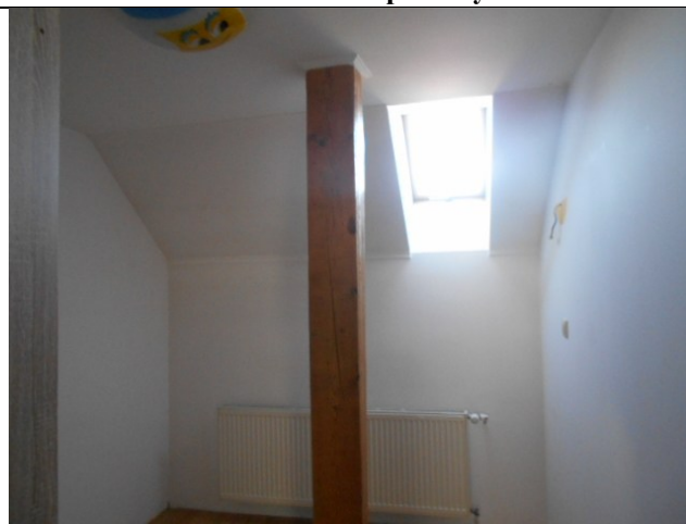
Pohľad na radiátor + okno v podkroví
