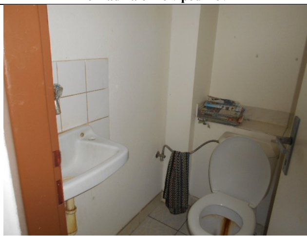
Pohľad na WC + umývadlo
