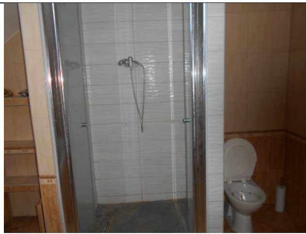
Pohľad na WC + sprchový kút
